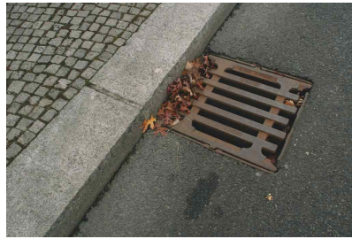
배수구, 하수관거 등 배수시설 점검
