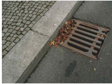
배수구, 하수관거 등 배수시설 점검
