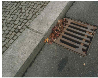
배수구, 하수관거 등 배수시설 점검
